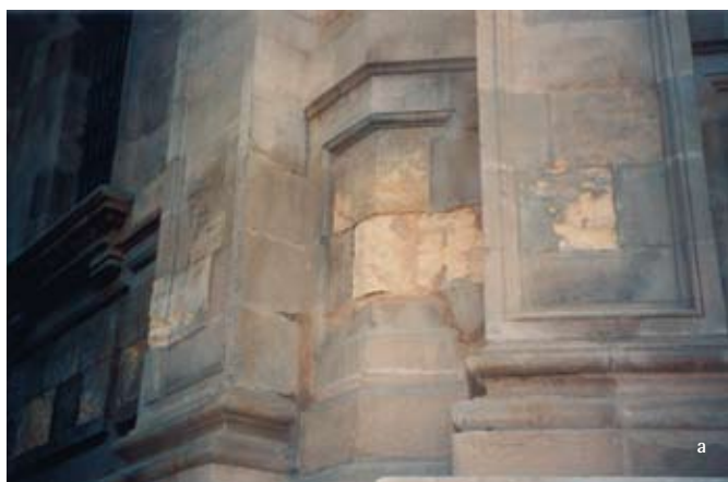
Estado de alteración del basamento del módulo C5 de la fachada oeste de la Catedral en 1988 (a) y en 2003 (b). Fotos: Manuel Alcalde Moreno (a) y María Gracia Gómez de Terreros (b)
