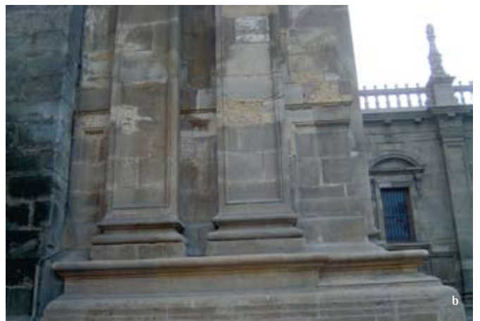
Estado de alteración de la zona de basamentos del módulo A de fachada oeste en 1988 (a) y en 2004 (b): Fotos: Manuel Alcalde Moreno (a) y María Gracia Gómez de Terreros (b)
