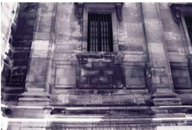
Estado de alteración que presentaba un módulo C3 de la fachada oeste en 1988 (a) y en 2004 (b). Fotos: M. Alcalde Moreno (a) y María Gracia Gómez de Terreros (b)
