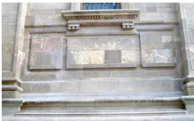
Estado de alteración del basamento del módulo C5 de la fachada oeste de la Catedral en 1988 (a) y en 2003 (b). Fotos: Manuel Alcalde Moreno (a) y María Gracia Gómez de Terreros (b)
