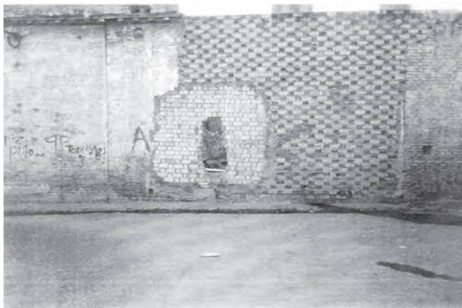
FIGURA 5. MURO EXTERIOR EN LOS PERDIGONES
