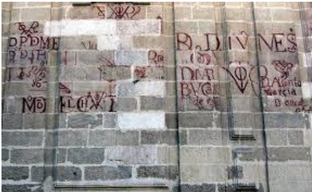
Fig. 1: Anónimos, Muro de la Catedral de Sevilla, 2017.
