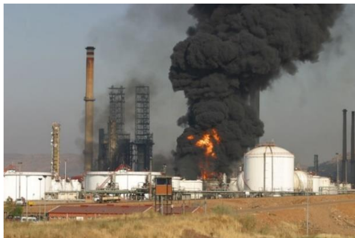
Figura 4-3. Incendio de los tanques de la Refinería de Repsol de Puertollano.
