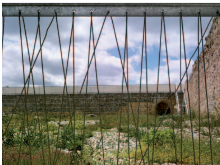
Detalle elemento de protección interior, con poterna al fondo. Foto: Jesús Granada
