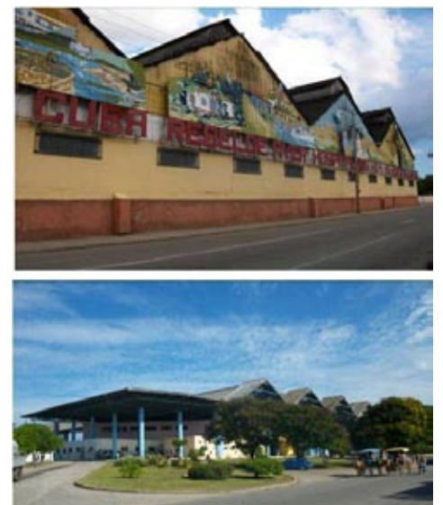
Figura 5: Grandes equipamientos en el sector de la Alameda.
