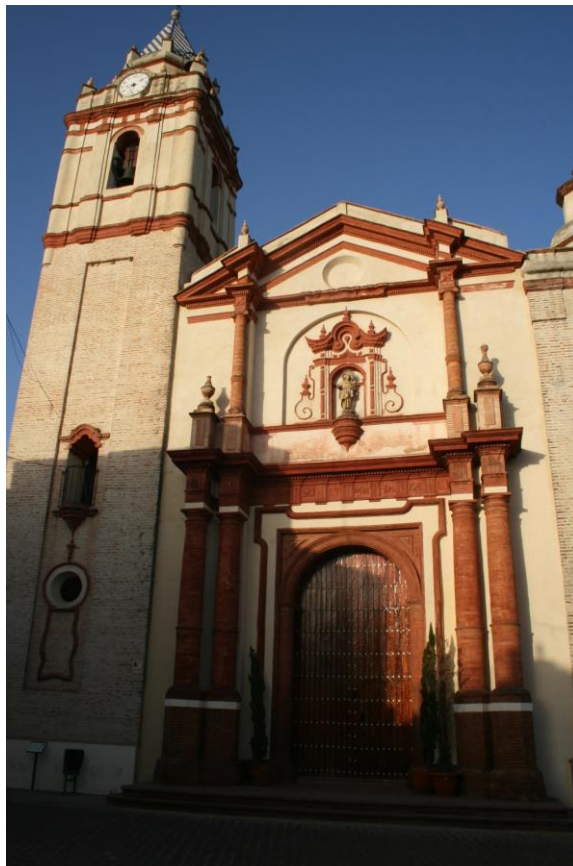
Fig. 4. Fachada de la iglesia de Nuestra Señora de Consolación de Aznalcóllar Sevilla. Foto del Autor.
