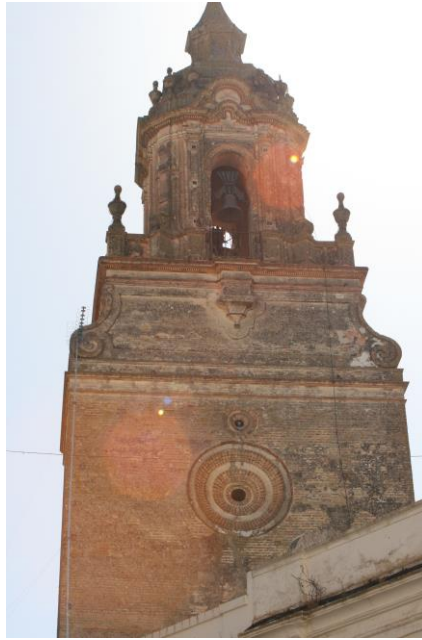
Fig. 3. Torre de la Iglesia de San Bartolomé de Carmona (Sevilla). Foto del autor.
