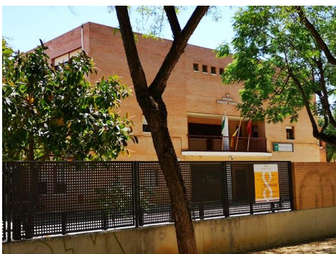
Figura 1. Fachada Colegio Escritor Alfonso Grosso, Sevilla. “Nota. Recuperado de Google Imágenes, s.f.”.
