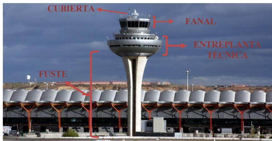
Figura 1-3. Partes de una torre de control
