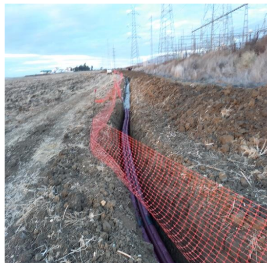
Tramo subterráneo de la línea de alta tensión
