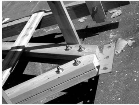
Figura 2. Ejemplo de unión con placa intercalada.
