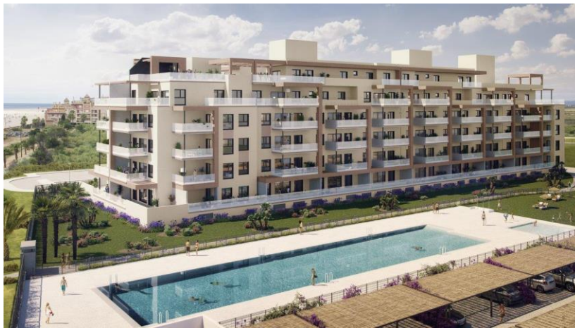
Figura 2. Vista en perspectiva del edificio de los Flamencos.
