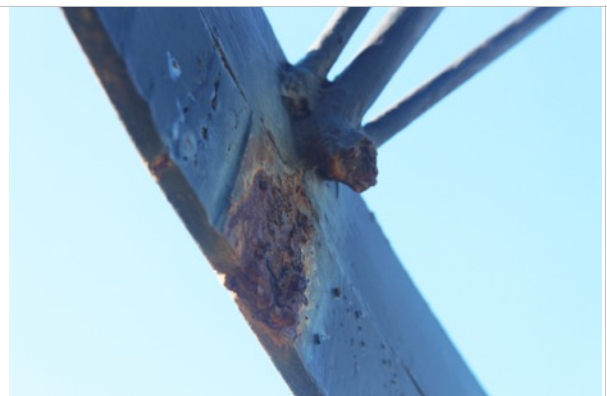
Figura 15 y 16. Figura 15 (izquierda), graffiti. Figura 16 (derecha), corrosión sobre una soldadura.
