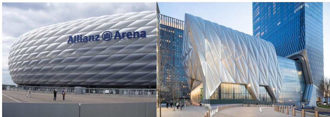
Ilustración 7. Estructuras con material EFTE. Imagen derecha: Edificio Allianz Arena en Munich. Imagen izquierda: Edificio Galea de Diller Scofidio + Renfro en Nueva York.
