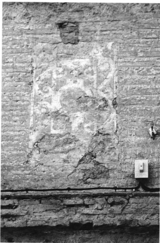
Fig. 3. Restos de esgrafiado en la vivienda del Ensayador. c/ Habana. Siglo XVI.
