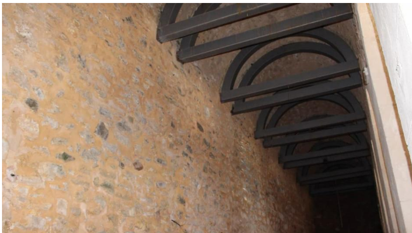
Imagen 14. Bóveda de cañón con estructuras de madera
