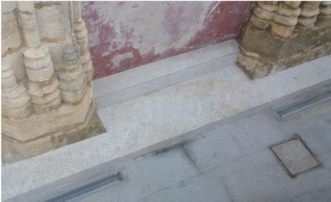
Imagen 36. Escalonada añadida con posterioridad de material «piedra natural de granito» blanco.
