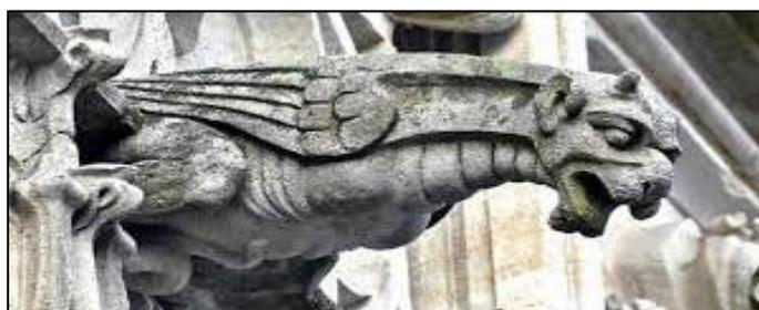
Ilustración 31. Gárgola para desagüe de las cubiertas.
