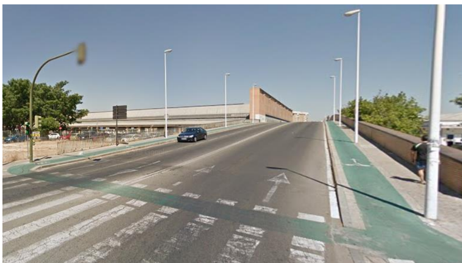
Figura 3-11. Vista Puente de la Calle Samaniego.
