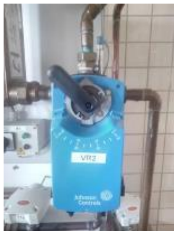
Figura 1.15: Válvula de regulación eléctrica
