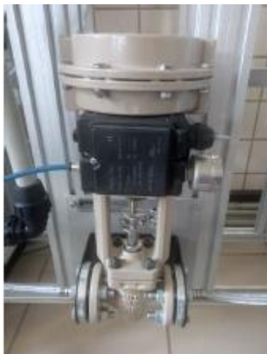
Figura 1.12: Válvula electro neumática de regulación
