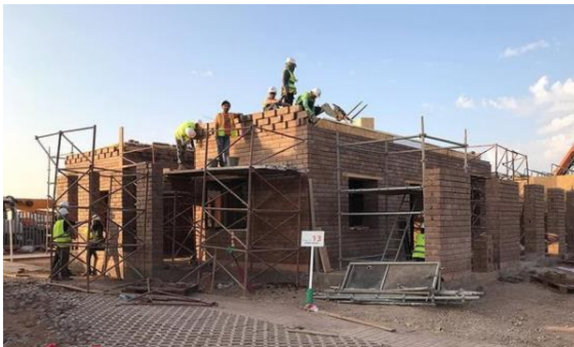
Ilustración 108 - Detalle de la construcción de la vivienda de Inter House en el Solar Decathlon África en 2019, en Ben Guerir. Extraído del Instagram Oficial del Equipo de Inter House.
