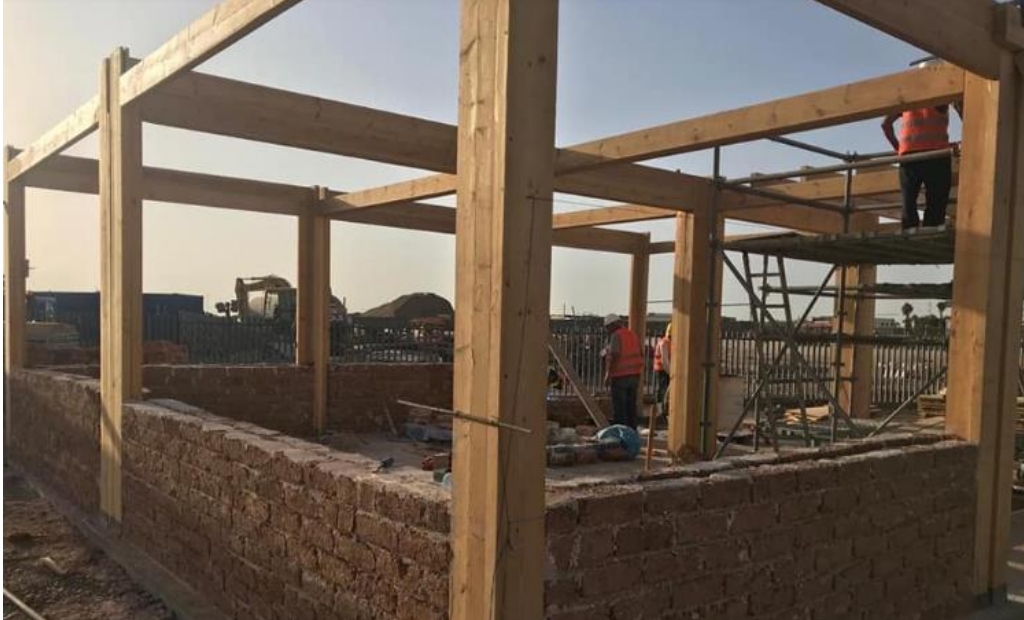
Ilustración 116 - Detalle de la Estructura de Madera de la vivienda de Bayti Akhdar en el Solar Decathlon África en 2019, en Ben Guerir. Extraído del Facebook Oficial del Equipo de Bayti Akhdar.
