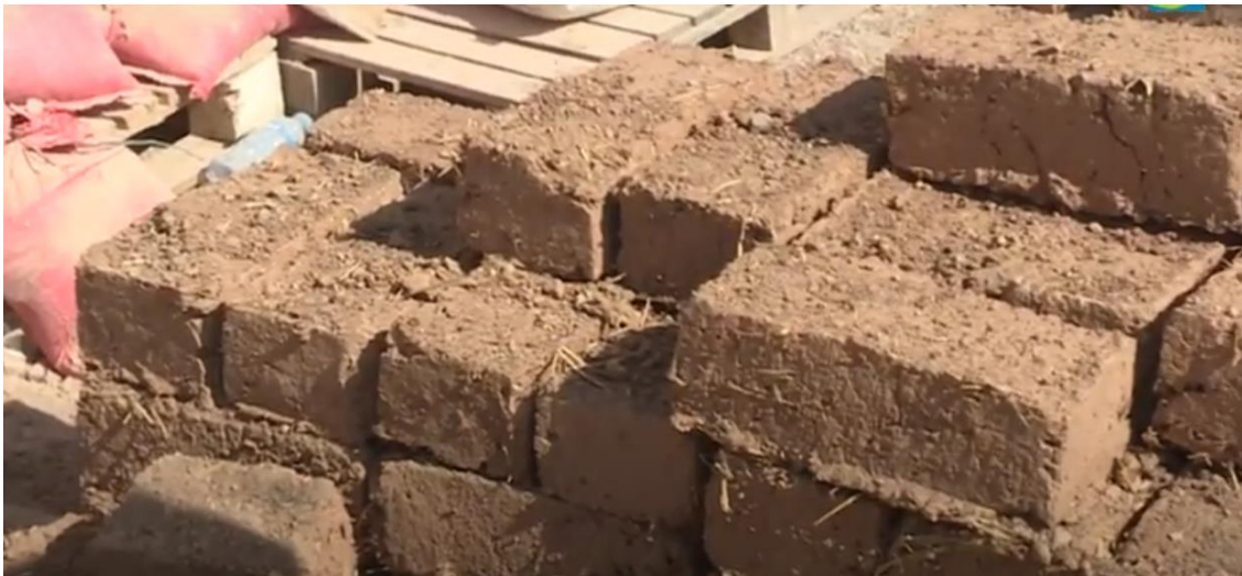
Ilustración 115 - Detalle de los bloques de tierra comprimidos utilizados en la construcción de las paredes de la vivienda de Bayti Akhdar en el Solar Decathlon África en 2019, en Ben Guerir. Extraído del Facebook Oficial del Equipo de Bayti Akhdar.
