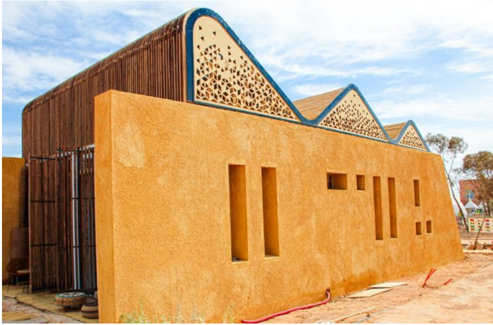
Ilustración 125 - Detalle de las aberturas en la lateral de la cubierta y los huecos pequeños dispuestos en la fachada oeste de la vivienda de Solar-Ution en el Solar Decathlon África en 2019, en Ben Guerir. Extraído del Facebook Oficial del Equipo de Solar-Ution.
