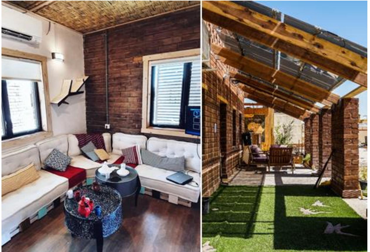
Ilustración 107 - Utilización de materiales autóctonos en la construcción del prototipo y de la utilización de estrategia de sombreado de ventanas. Obtenido de: https://www.solardecathlonafrika.com
