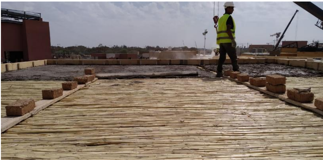
Ilustración 117 - Detalle de la construcción del techo de la vivienda de Bayti Akhdar en el Solar Decathlon África en 2019, en Ben Guerir. Extraído del Facebook Oficial del Equipo de Bayti Akhdar.
