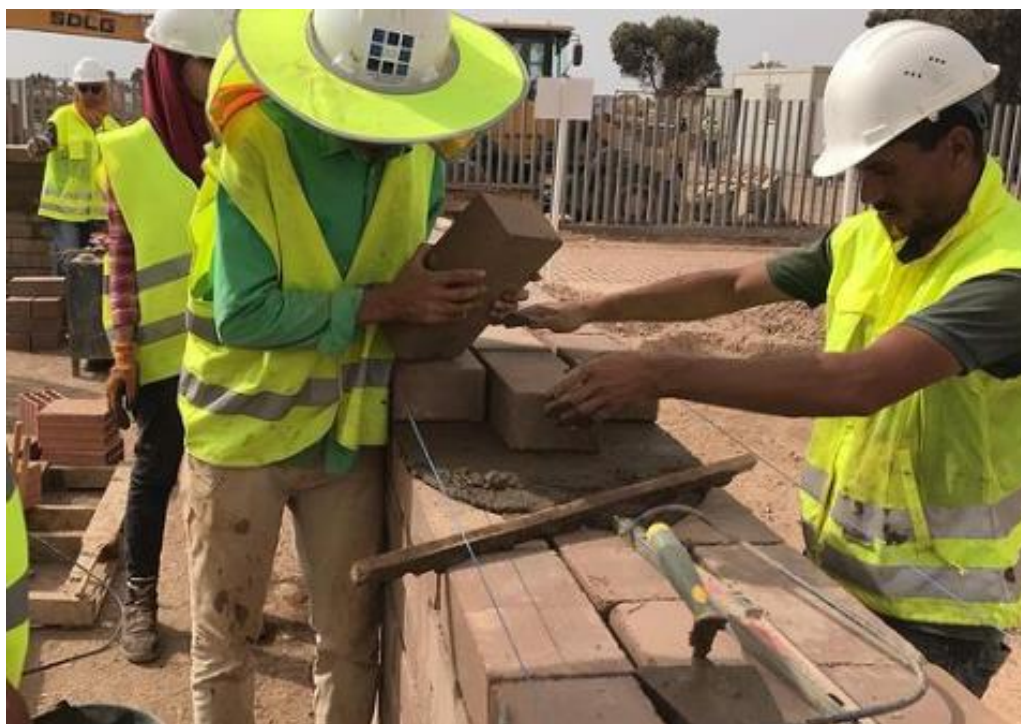
Ilustración 109 - Detalle de la construcción de la vivienda de Inter House en el Solar Decathlon África en 2019, en Ben Guerir. Extraído del Instagram Oficial del Equipo de Inter House.
