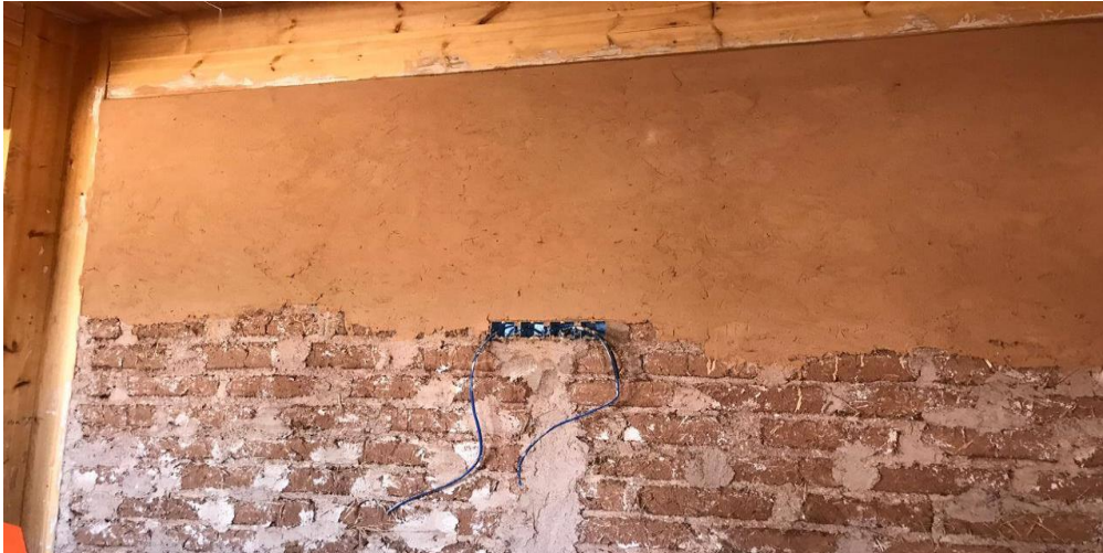
Ilustración 118 - Detalle de la utilización de tierra como revestimiento de acabado interno de las paredes de la vivienda de Bayti Akhdar en el Solar Decathlon África en 2019, en Ben Guerir. Extraído del Facebook Oficial del Equipo de Bayti Akhdar.
