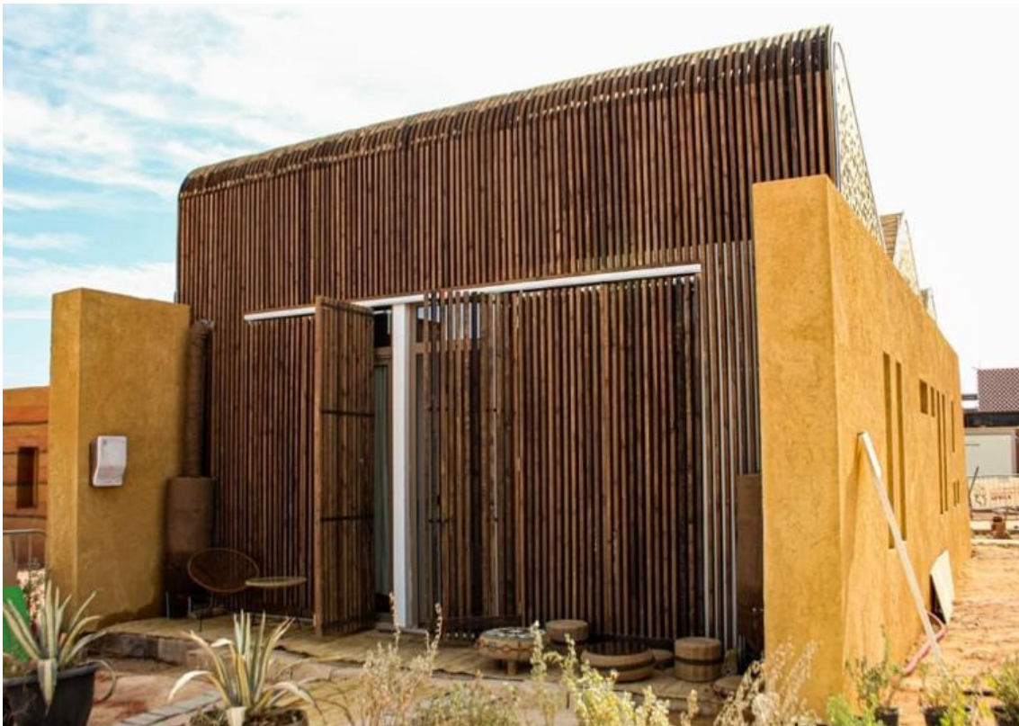
Ilustración 124 - Detalle de las lamas para protección solar de la fachada norte de la vivienda de Solar-Ution en el Solar Decathlon África en 2019, en Ben Guerir. Extraído del Facebook Oficial del Equipo de Solar-Ution.
