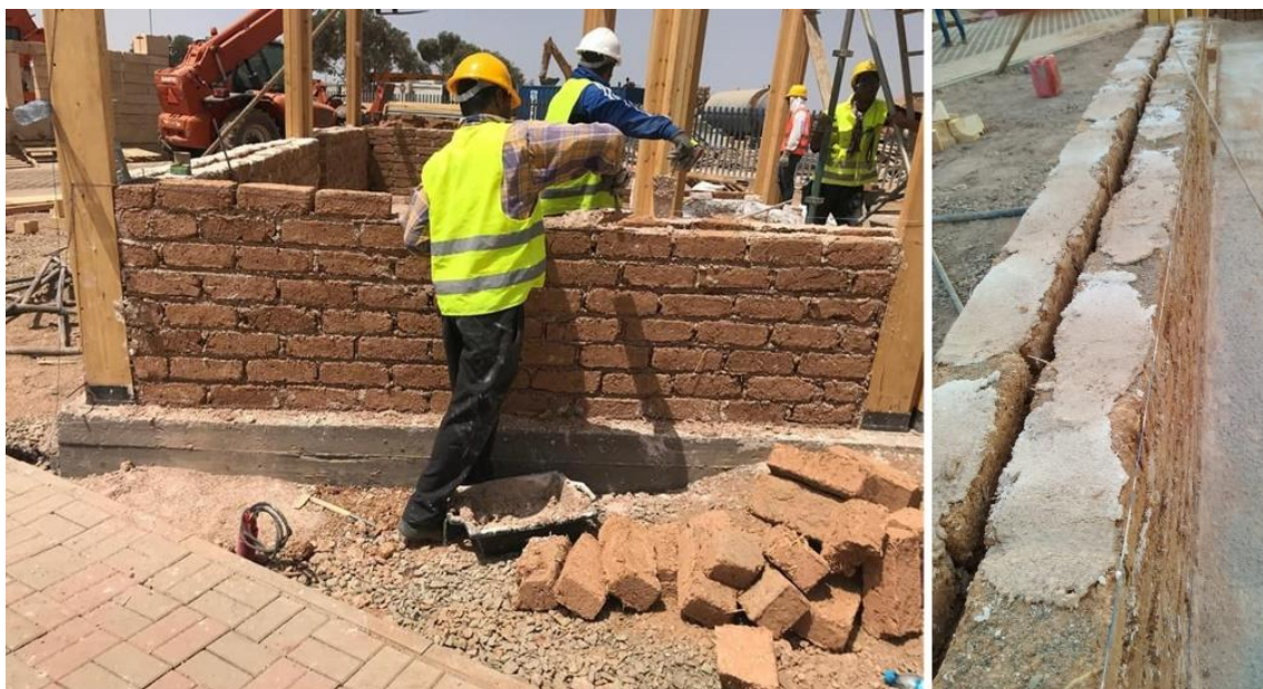
Ilustración 113 - Detalle de la construcción de la vivienda de Bayti Akhdar en el Solar Decathlon África en 2019, en Ben Guerir. Extraído del Facebook Oficial del Equipo de Bayti Akhdar.
