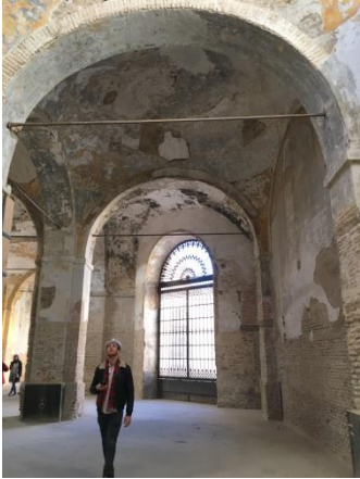
Zona fundición menor
