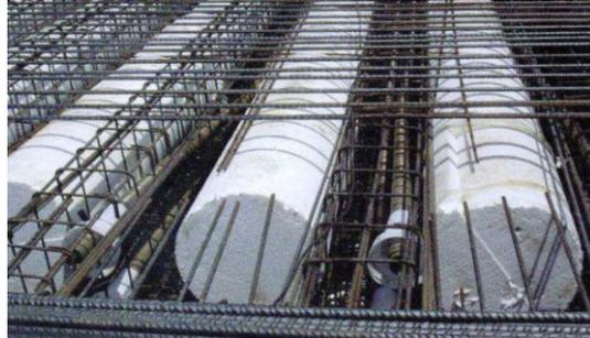
Losa aligerada con piezas cilíndricas de porexpan
