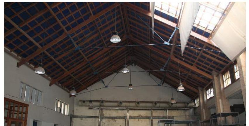
Fig. 13 Vista del interior de la nave y la estructura de cercha mixta tipo Polonceau. Foto del autor.
