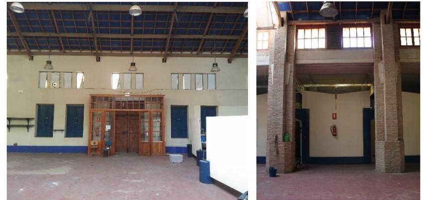
Fig. 8 Vista interior del muro de fachada. Fig. 9 Vista de los pilares cruciformes de fábrica de ladrillo con base octogonal. Fotos del Autor.
