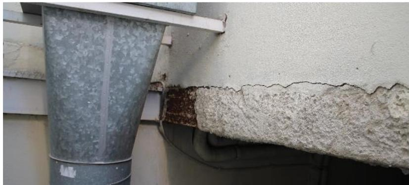
Fig. 45 Desprendimiento de mortero proyectado y corrosión de perfil en zona de escalera.
