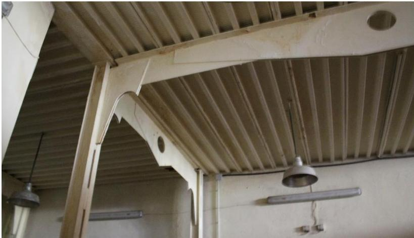
Fig. 14 Vista de vigas tipo boid bajo forjado de chapa colaborante y apoyados en pilares de acero. Foto del Autor.
