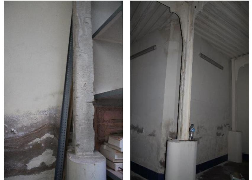
Fig. 46 Desprendimiento de mortero proyectado en pilar (zona de servicios). 47. Algunos signos de corrosión de pilar metálico central. 48. Humedades por filtración desde la cubierta plana en pilar cruciforme de fábrica de ladrillo. Fotos del autor.
