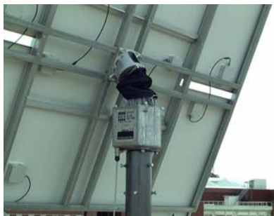
Figura 2: Sistema de posicionamiento angular de paneles fotovoltaicos
