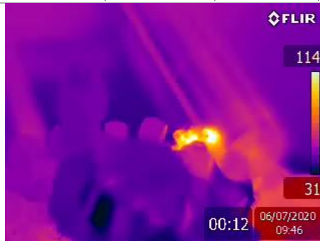
Figura B.4 Imagen térmica del ensayo 2.4
