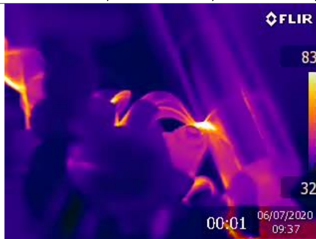
Figura B.11 Imagen térmica del ensayo 2.11
