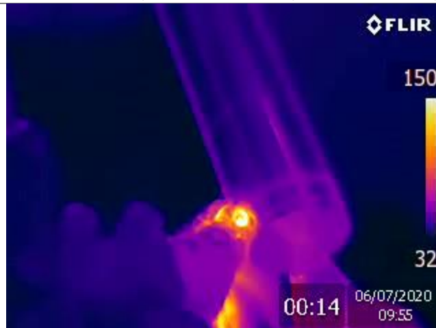
Figura B.22 Imagen térmica del ensayo 2.22
