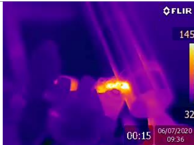
Figura B.10 Imagen térmica del ensayo 2.10
