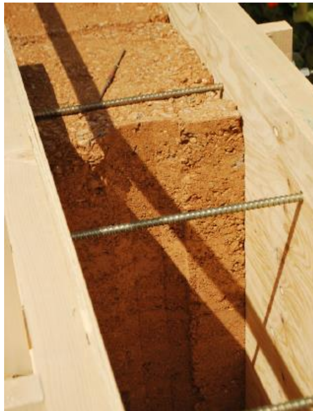
Figura 22. Detalle de la conexión macho-hembra entre elementos de tierra. Elementos que componen el encofrado.
