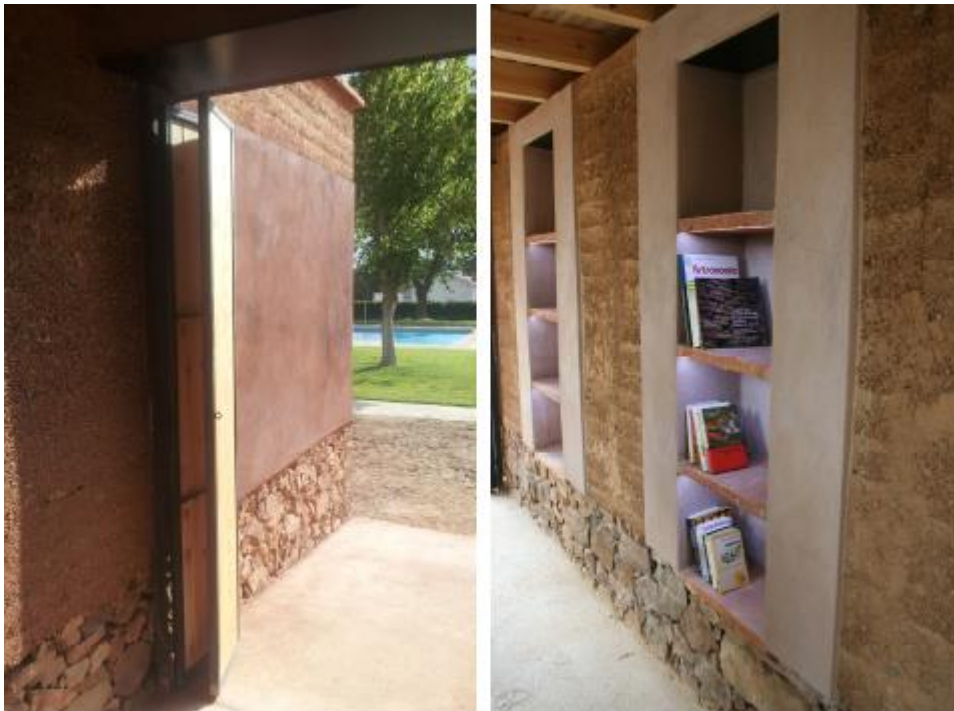
Figura 24. Fotografía del interior de la construcción. Detalle del recubrimiento de mortero cercano a la puerta frontal y en las tres hornacinas.
