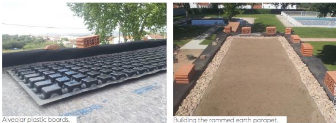
Figura 14. Proceso de construcción de la cubierta
