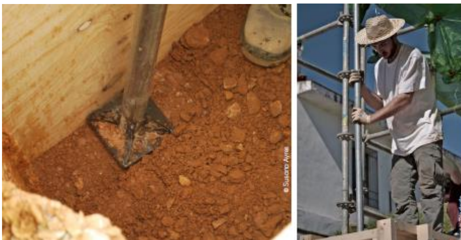
Figura 11. Compactación in situ
