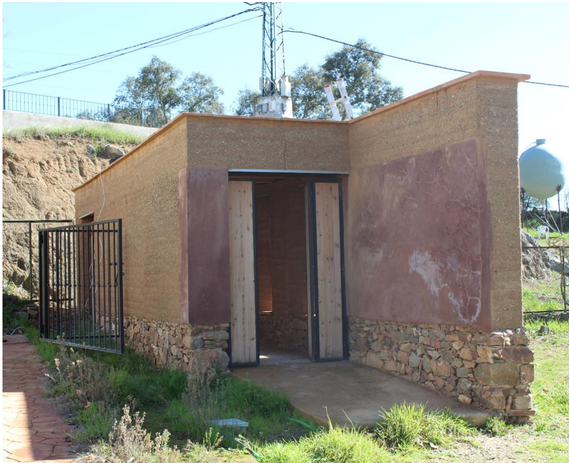
Figura 15. Vista frontal de la estructura.
