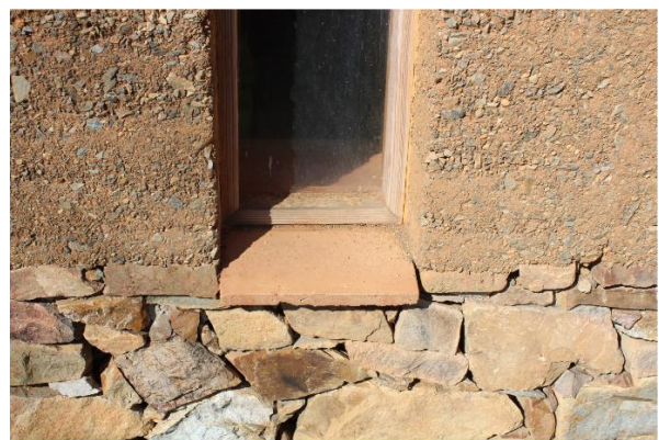
Figura 16. A) Lavado de finos en los pretiles. B) Material fino acumulado en el alféizar de las ventanas
