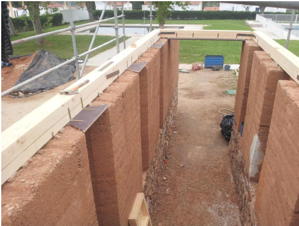
Figura 12. Construcción de la viga collar
