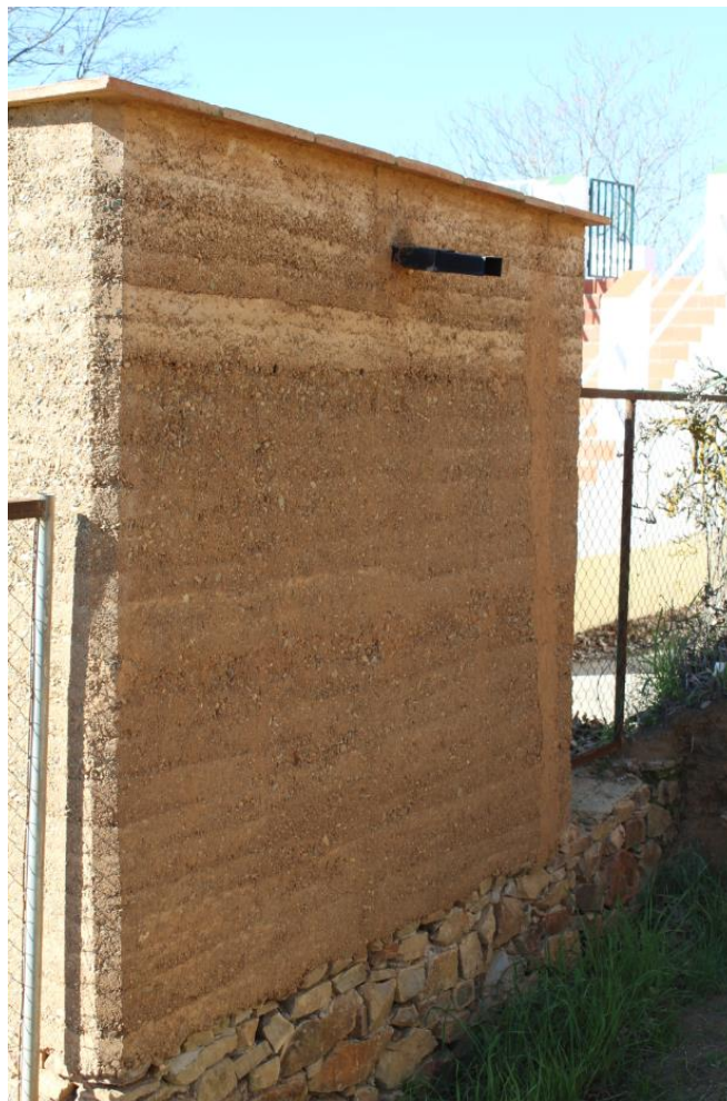
Figura 26. Vista trasera de gárgola de evacuación pluvial y chafalán en las esquinas de los muros
