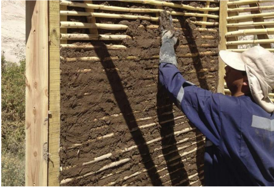
Figura 5. Proceso de construcción de un muro de quincha
