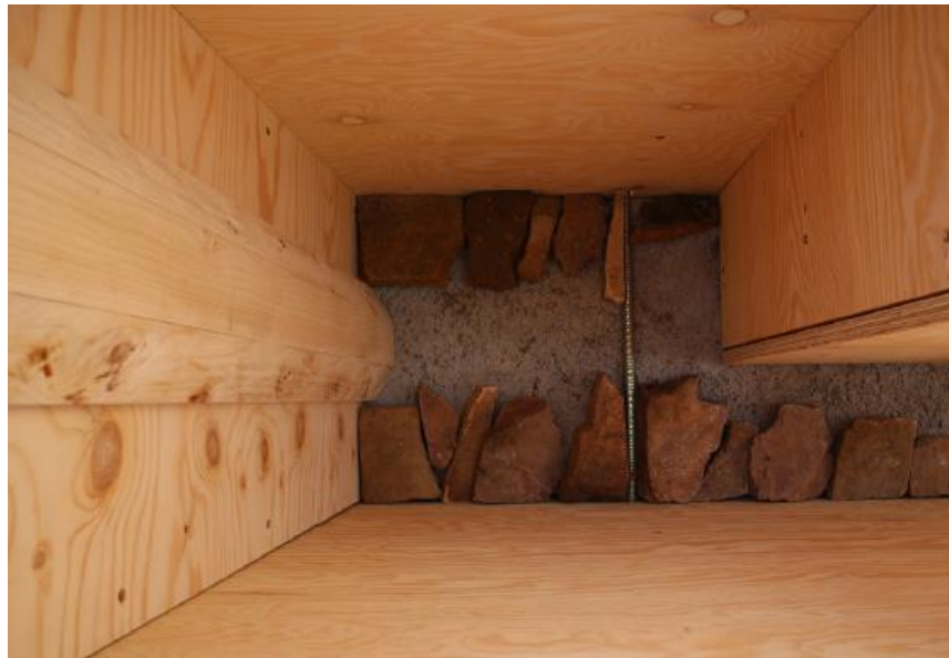
Figura 21. Piedras colocadas para rellenar el espacio entre el sobrecimiento
