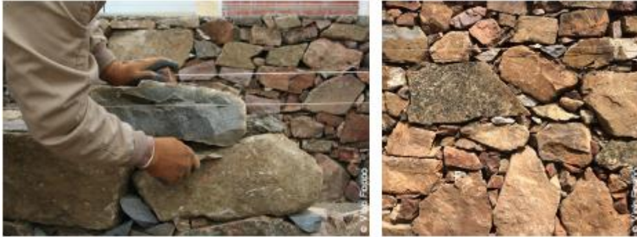
Figura 10. Construcción del sobrecimiento
