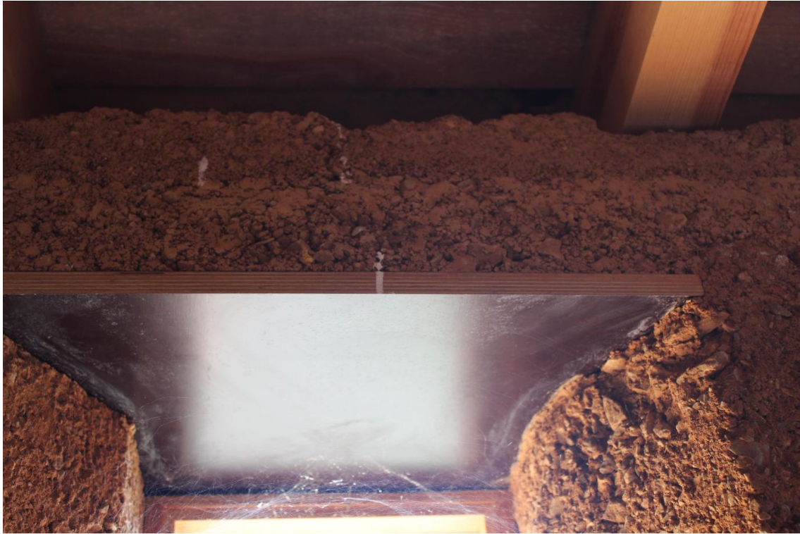
Figura 17. Heterogeneidad de la tapia en la zona superior del muro
