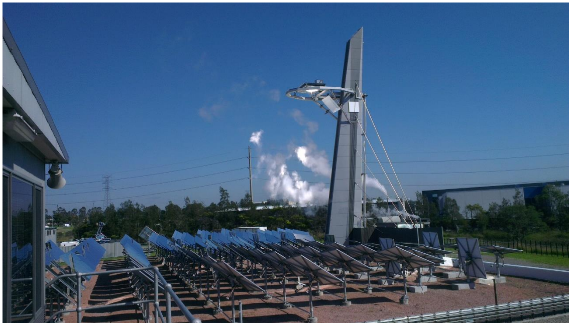
Ilustración 34: Campo solar de CSIRO dónde se llevó a cabo la demostración de la obtención de vapor supercrítico en centrales solares térmicas. [15]
