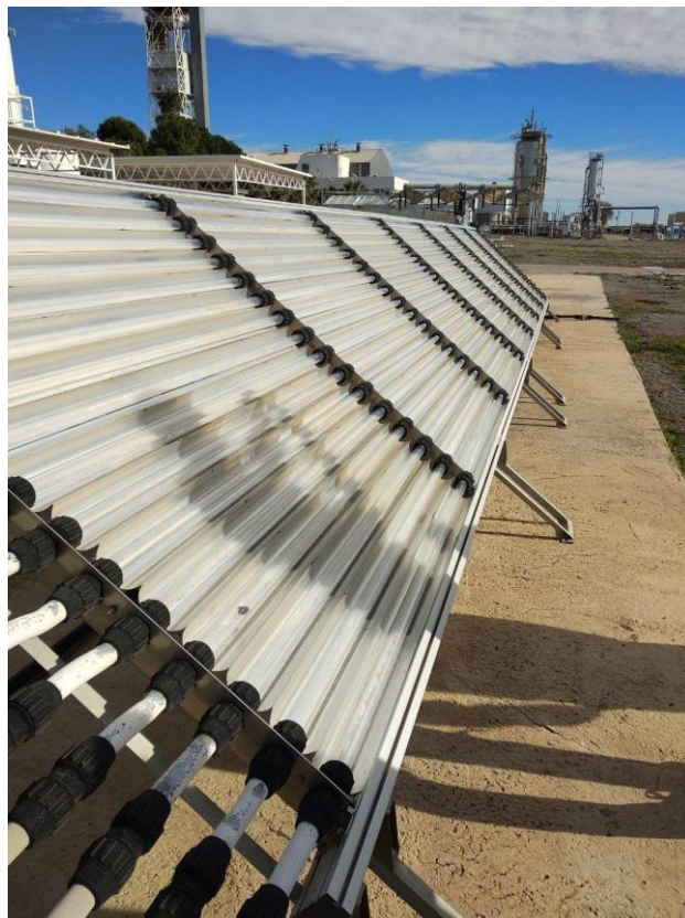
Ilustración 10: Energía solar para la desinfección de agua potable. Fuente: Elaboración propia
