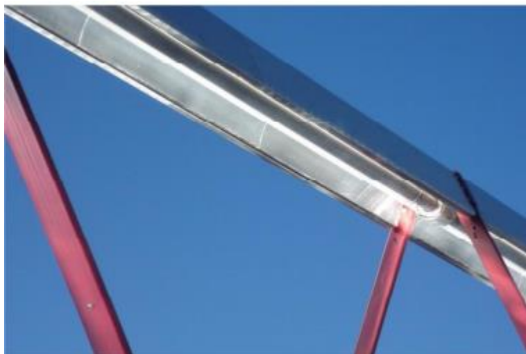
Ilustración 5: Reflector secundario en colector Fresnel ubicado en la ETSI en Sevilla. [2]
