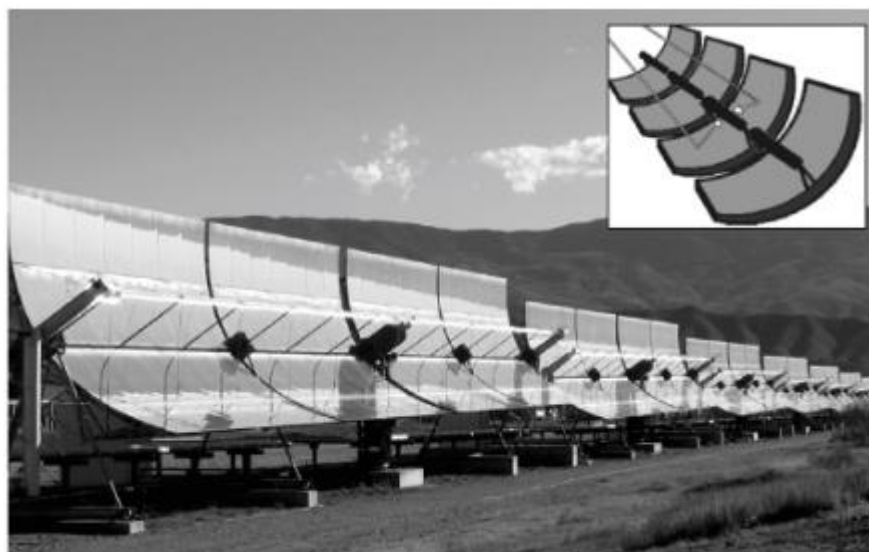
Ilustración 2: Colector cilindro-parabólico. [1]
