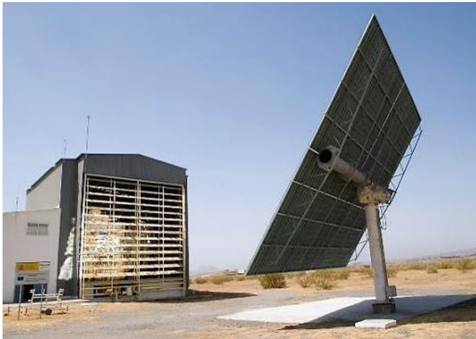
Ilustración 8: horno solar SF-60 de CIEMAT. Fuente: Riteca.
