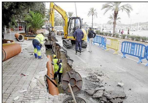
Figura 3. Obras de Reparación de la Red de Abastecimiento de Eivissa.
