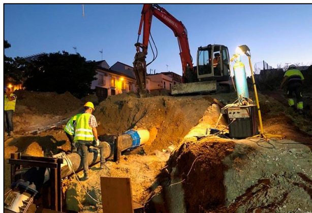
Figura 4. Reparación de tubería de Abastecimiento (Montilla).
