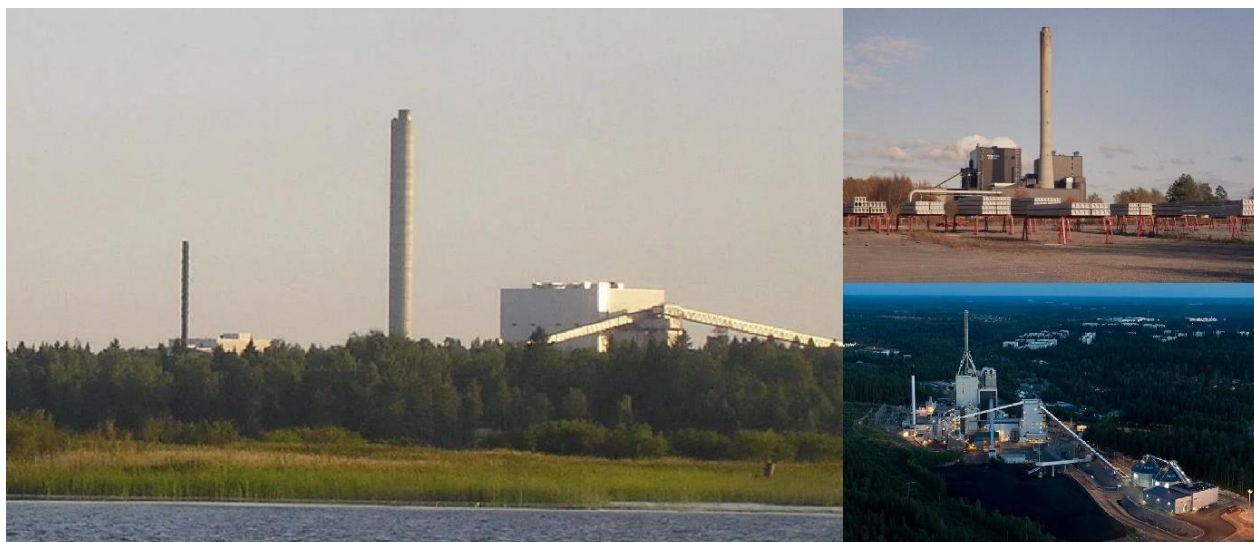
Figura 3. Mayores plantas de biomasa en Finlandia. A la izquierda AlholmensKraft (265 MW). A la derecha arriba Toppila (210 MW). A la derecha abajo Kymijärvi II (160 MW).
