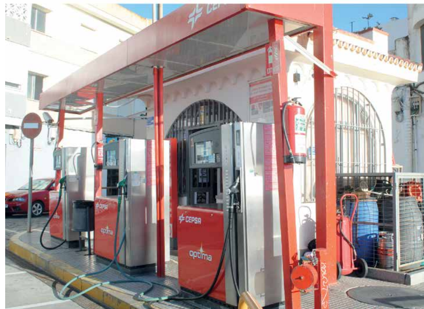
Fig. 13.1: Gasolinera de Ricardito /octubre de 2020 / Autor: Marta Mirabent / Localización: Colección particular de la autora.
