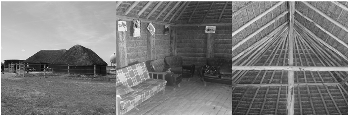
Figura 15. Chozo del Pastor: exterior, interior, estructura
