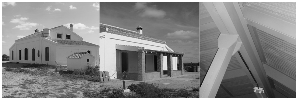
Figura 10. Casa de la Pichiricha: fachada trasera, porche delantero, estructura de cubierta
