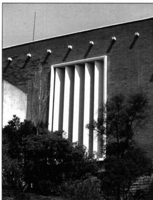
Figura 26.- Aplicación de los composites en ventanas y lamas. Sustitución de elementos deteriorados a la intemperie por elementos de composite (Instituto Eduardo Torroja) (\*).
