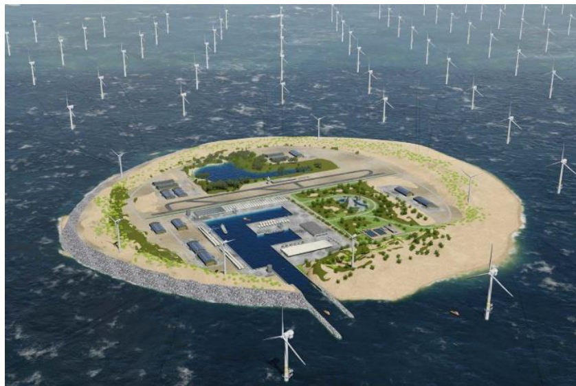
Ilustración 29: Estructura de una de las islas piloto del proyecto NSWPH [66].
