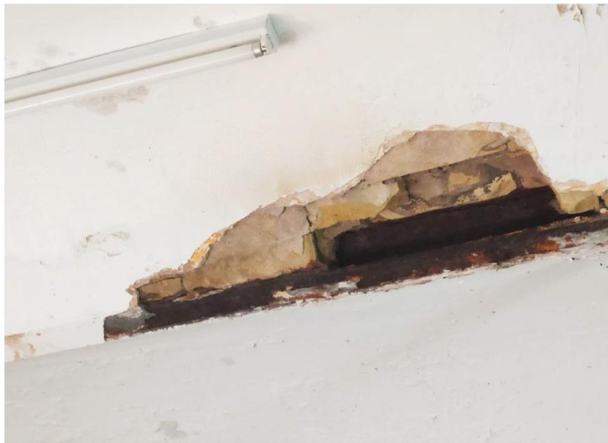
Figura 22. Fotografía de una de las catas realizadas, donde se observa el deterioro existente en el perfil. Fuente: Informe Técnico de José Manuel Mena Toledo (Arquitecto)
