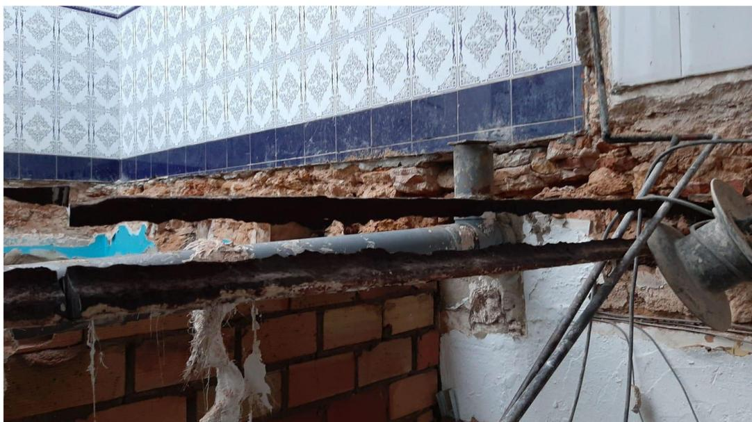
Figura 24. Perfil con pérdida completa de la sección en el alma. Fuente: Informe Técnico de José Manuel Mena Toledo (Arquitecto)
