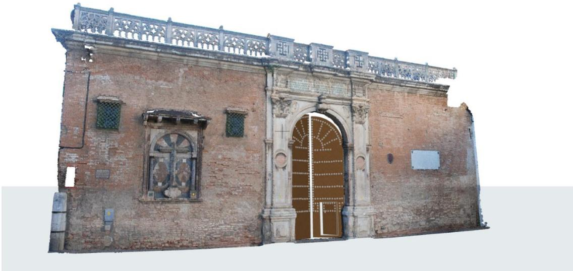
Figura 41. “Fachada principal de la Casa de Pilatos. Nube de puntos para la fachada y objetos sólidos para las puertas”. Imagen del autor
