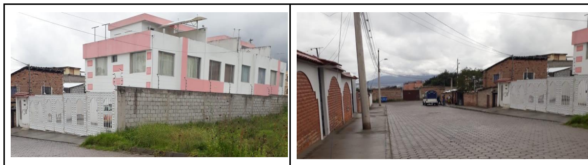
Figura 8-25. Estado de conservación de edificaciones cercanas al solar elegido.
