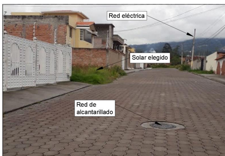
Figura 8-70. Red de alcantarillado y red eléctrica, disponibles en el solar elegido.
