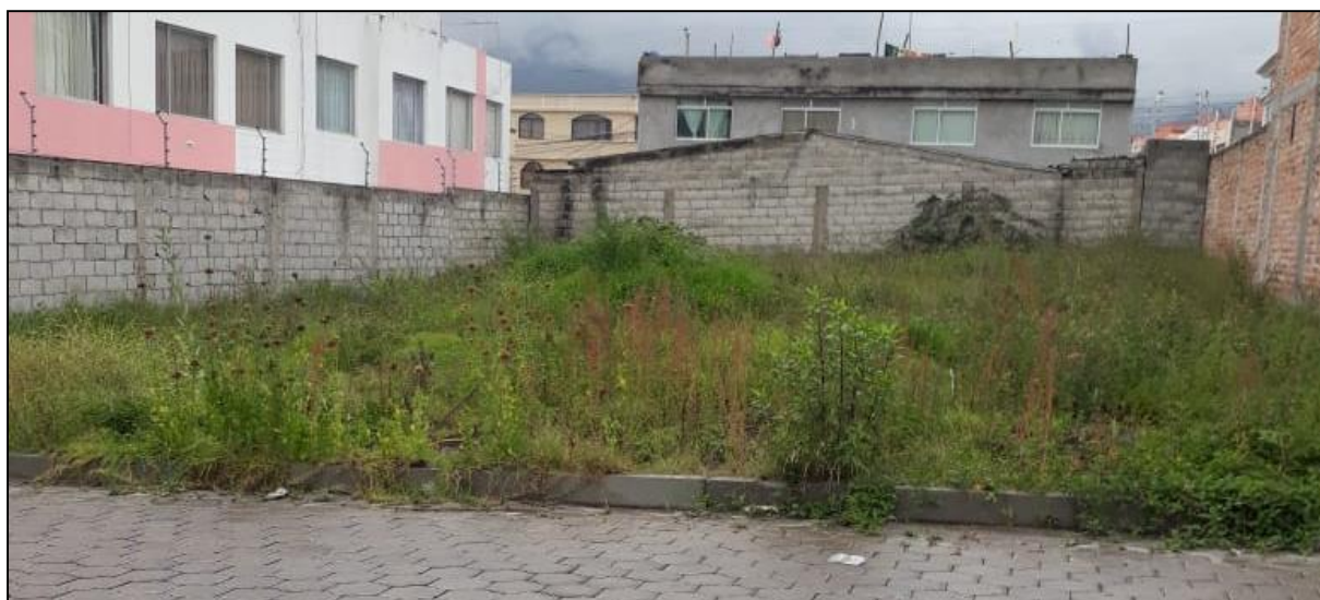
Figura 8-64. Obras de urbanización complementaria, aceras faltantes.
