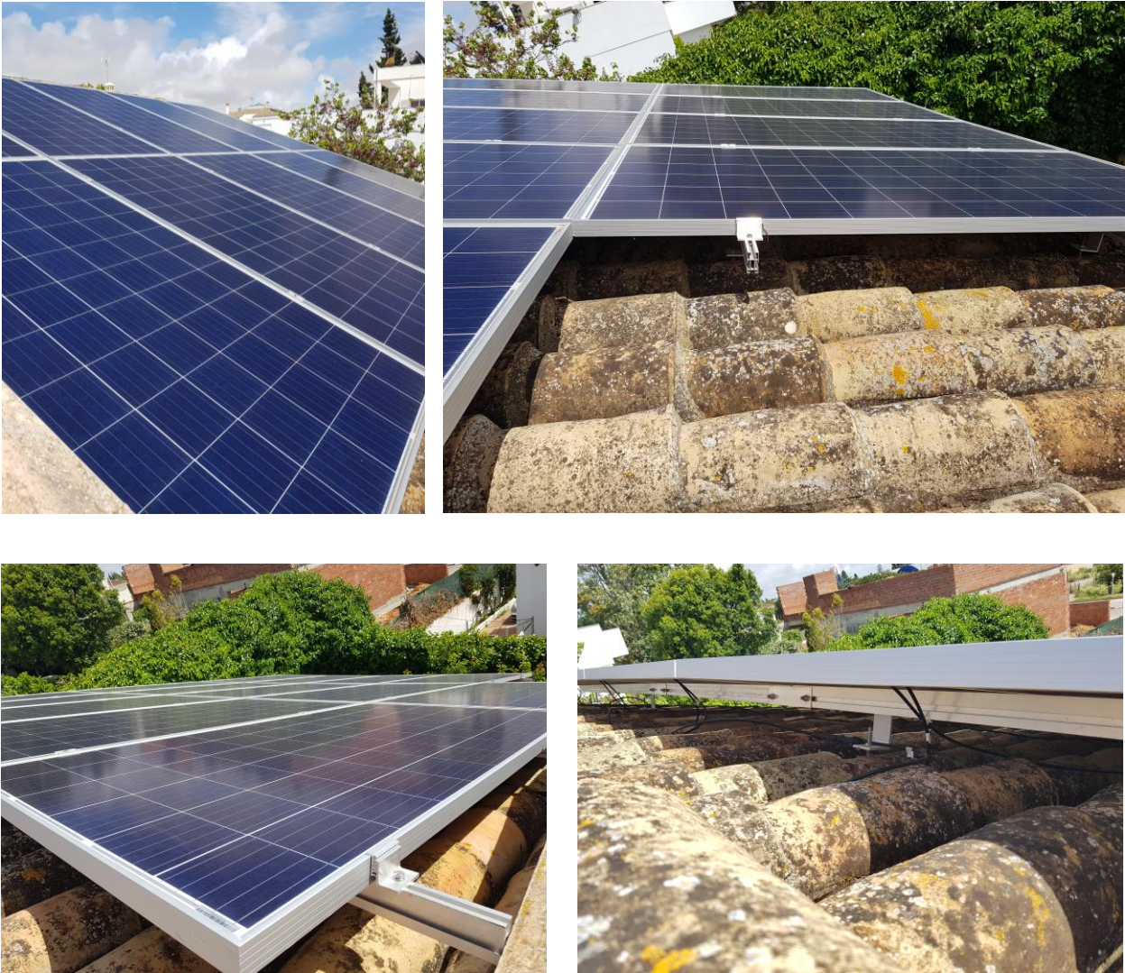
Figura 36. Fotografías in situ de instalación de placas fotovoltaicas en la cubierta de una vivienda
