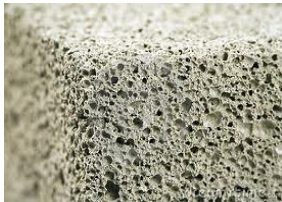
Fig. 33. Formación de pendiente con hormigón celular
