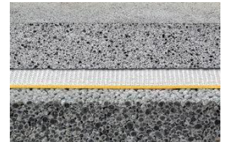
Fig. 36. Formación de pendiente con morteros aligerados
