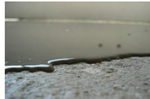
Fig. 35. Formación de pendiente con mortero de nivelación
