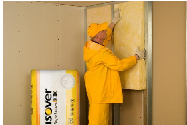
Fig. 36. Colocación de paneles de lana mineral en la estructura metálica. Fuente: DecorexPro, https://es.decorexpro.com/uteplenie/naruzhnoe/isover-dlya-fasada/
