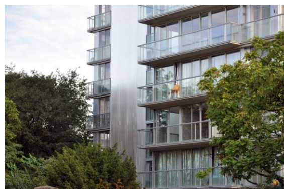
Figura 64. Vista exterior del edificio rehabilitado y las cortinas térmicas. (Druot, Lacaton, & Vassal, 2011)
