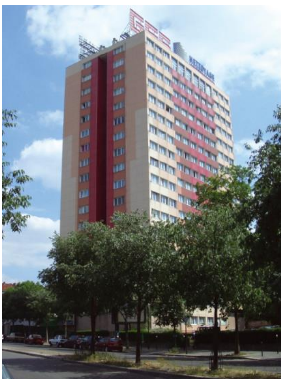
Figura 62. Edificio tras la primera rehabilitación de autor desconocido. (Druot, Lacaton, & Vassal, 2011)
