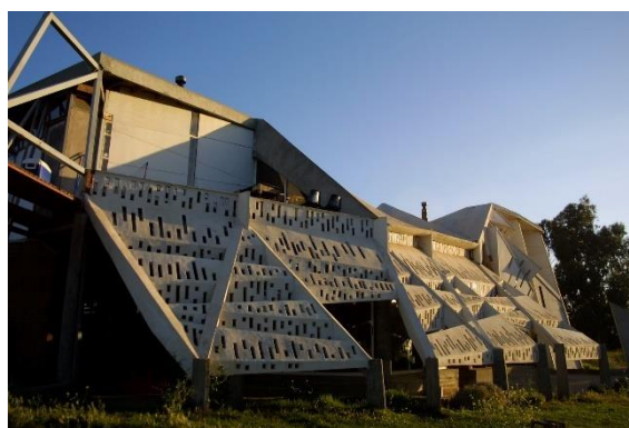
Figura 47. Celosías de la fachada sur. (CiudadAbierta, 2018)
