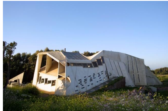
Figura 40. Vista exterior de la Hospedería del Errante (fachada norte). (CiudadAbierta, 2018)
