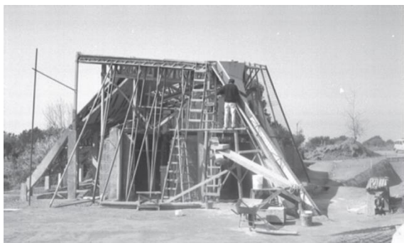
Figura 45. Proceso de construcción de la Hospedería del Errante. Año 1997. (Millán-Millán, 2019, p. 113).
