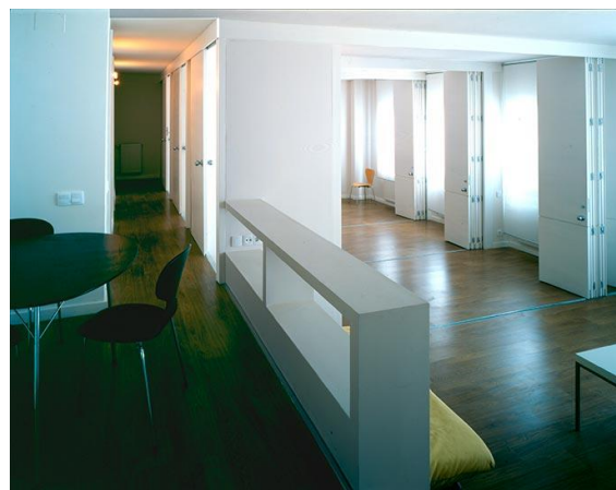
Figura 69. Vista interior de la vivienda. Espacio con tabiques móviles. (Sánchez, 2005)
