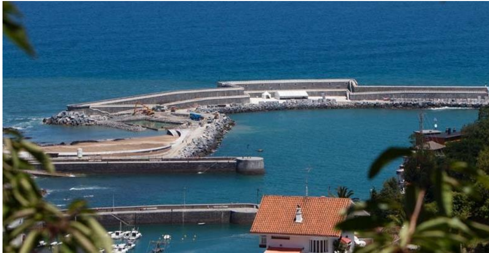
Figura 1-7. Dique de la central undimotriz de Mutriku[23]
