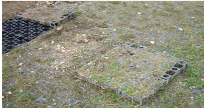
Figura 1-2. Pavimento permeable discontinuos con celdas de plástico.
