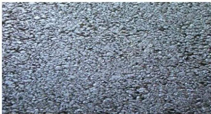
Figura 1-3. Pavimento asfáltico poroso.
