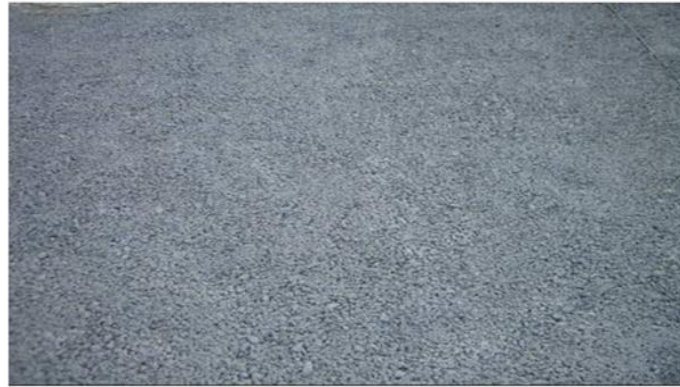
Figura 1-4. Pavimento de hormigón poroso.
