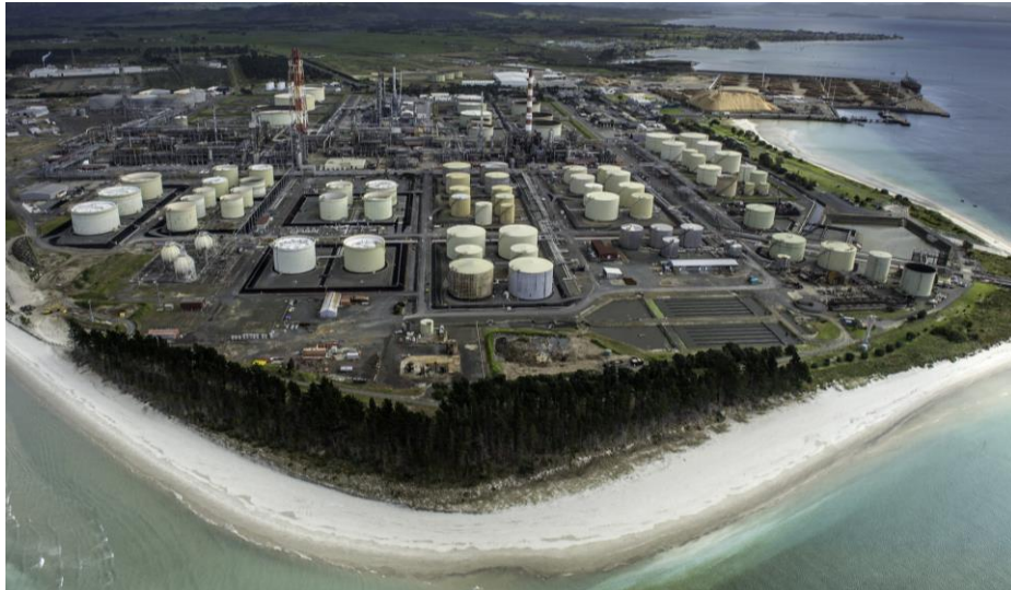
Figura 15. Vista aérea refinería Marsden Point.
