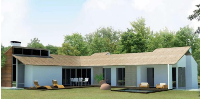
Ilustración 12. Vivienda de 136 m 2
