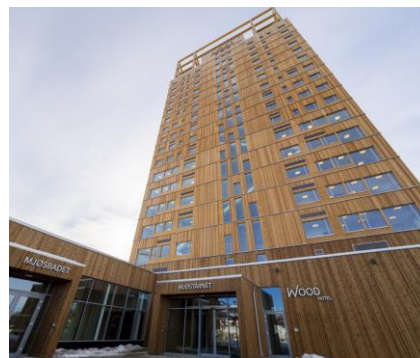
Ilustración 6. Mayor edificio con estructura de madera
