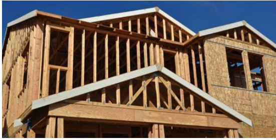
Ilustración 2. Construcción de madera laminada
