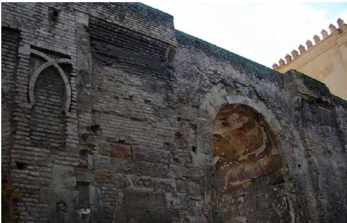
Imagen XXI Inserción en las estructuras actuales.
