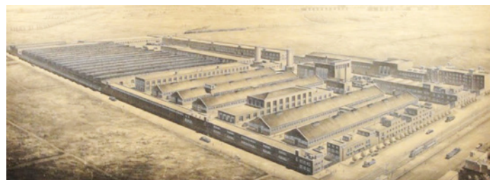
■ Fig. 3. HYTASA Ciudad Industrial. Perspectiva del proyecto de Galnares recogiendo las cuatro primeras primeras naves de Talavera
