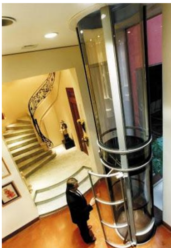
Figura 4 Ascensor dedicado a mejorar la accesibilidad de la vivienda
