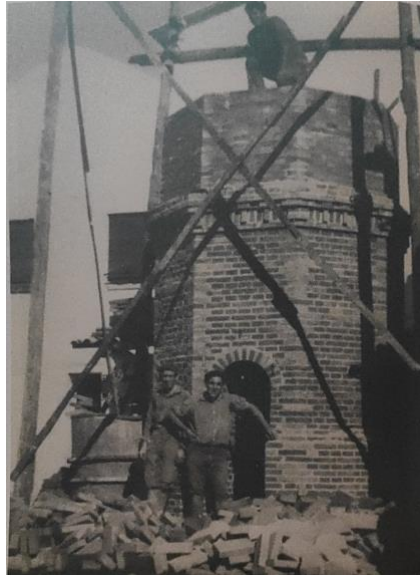
Figura 2.6. Construcción de una chimenea alcoholera
