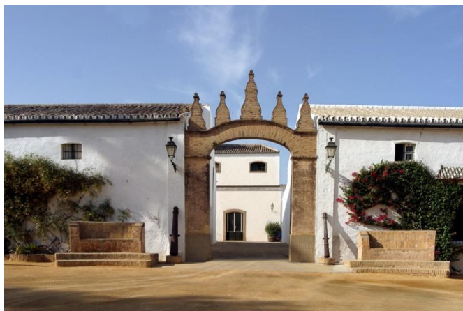
Figura 3.2. Fachada de la Hacienda Pata de Hierro
