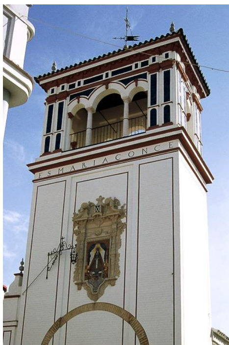
Figura 3.5. Torre de contrapeso de la Hacienda Montefuerte
