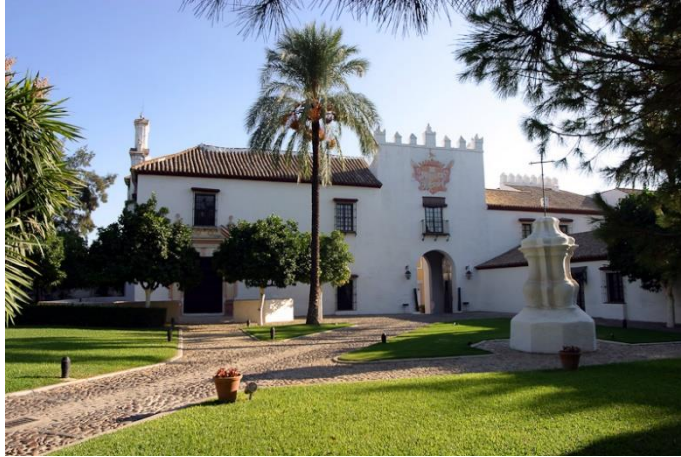
Figura 3.7. Patio y fachada principal de la Hacienda Benazuza
