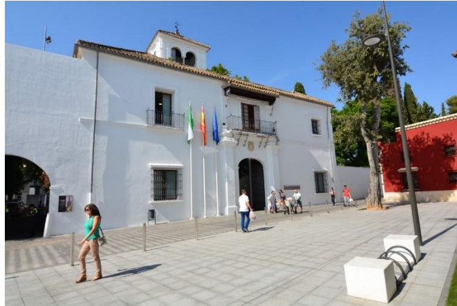
Figura 3.4. Fachada principal de la Hacienda Santa Ana
