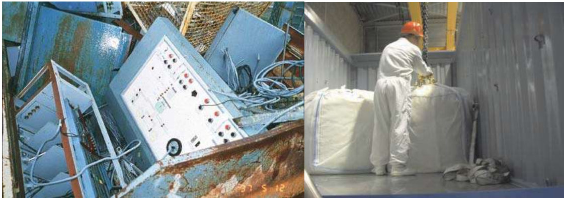
Figura 2. A la izquierda, equipamiento viejo de laboratorio que ha estado en contacto con elementos radiactivos, dispuesto en vertederos para residuos de muy baja actividad. A la derecha, bolsas de escombros para evitar la dispersión de polvo. [6]
