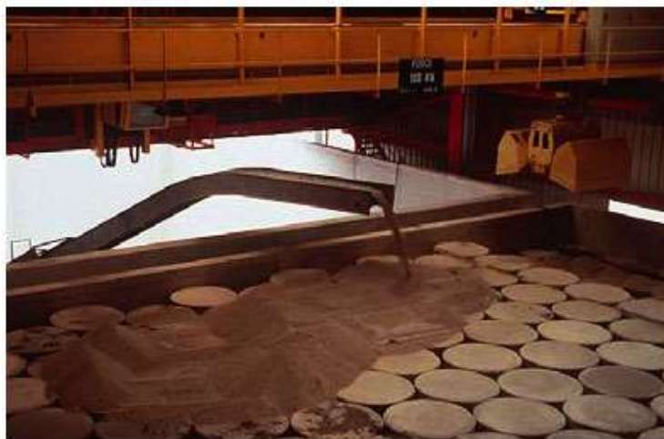
Figura 4. Barriles de residuos, apilados y posteriormente cubiertos por cemento en un almacén superficial construido sobre terreno arcilloso. Es el centro de almacenamiento de Aube, Francia. Los residuos almacenados, junto a la clase anterior forman la mayor parte de los residuos radiactivos que se producen a nivel general. A pesar de las medidas de seguridad, son los que poseen menor riesgo para el medio ambiente, debido a la poca abundancia de núclidos radiactivos y al relativamente corto tiempo de semivida. (Fuente: ANDRA/Michel Dutzer)
