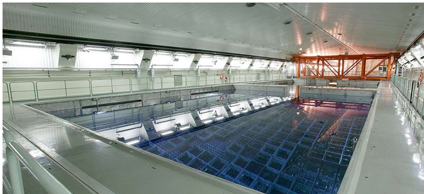
Figura 23. Suecia no reprocesa su combustible gastado. Desde 1985, dichos residuos se recogen y almacenan en piscinas en una cavidad excavada a 30 m bajo tierra. La capacidad de almacenamiento de estas piscinas alcanza las 11.000 toneladas. Los conjuntos de combustible son visibles bajo el agua. [28]
