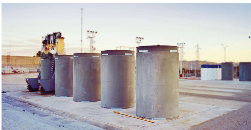
Figura 29. ATI en la central nuclear de Ascó. Por cortesía de IDOM.
