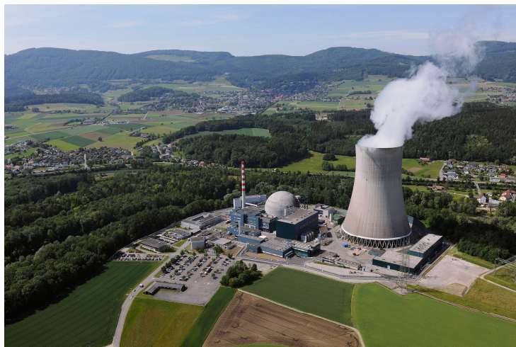
Figura 24. Central Nuclear de Gösgen. Presenta un único reactor LWR La matriz del núcleo del reactor contiene 177 elementos combustibles, 48 de los cuales están equipados con barras de control. Cada elemento combustible puede contener hasta 225 barras, pero solo 205 (204 para los MOX) están ocupadas por el combustible. Los 20 huecos restantes están reservados a las barras de control. El reactor en funcionamiento contiene un total de 76 tm de uranio. Funciona a 324° C y 153 bar. La potencia térmica de salida alcanza 3002 MW. La potencia eléctrica neta alcanza los 970MWe, que son suministrados a la red de 400kV. [29]
